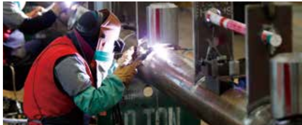
용접대선(모재)/용접봉/용접사의 색이 일치함을 한눈에 파악하여 품질 CTQ가 만족하는지 쉽게 확인할 수 있음
