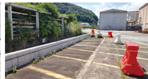
범람 취약 지역 차수벽 설치
