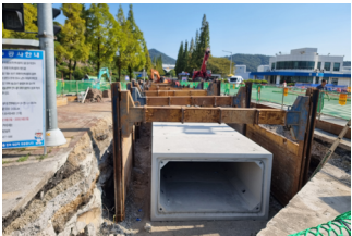
정문 추가 배수관 설치
