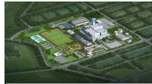
함안복합 (EPC 공사)
